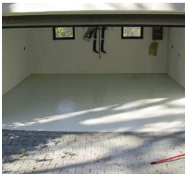
Podlaha aplikovaná pomocí potěru PCI ZemTec® 2K s finální povrchovou úpravou PCI ZemTec® F.
