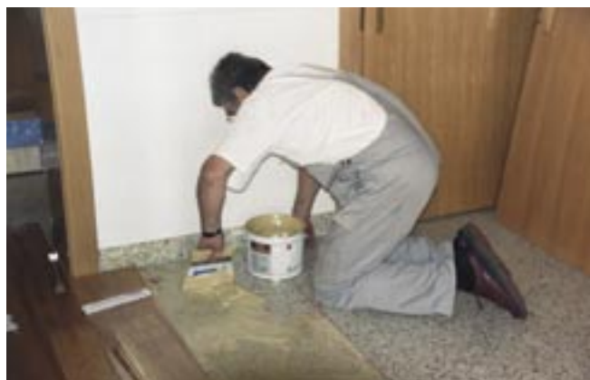
Pokládka exotických parket na nesavý podklad pomocí 1K-PU lepidla na parkety PAR 364.
