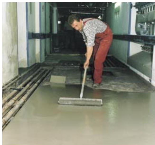
Aplikace potěru PCI ZemTec® 1K.
