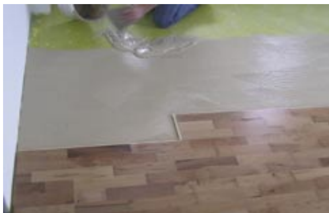
Lepení dvouvrstvých parket pomocí Práškového lepidla na parkety PAR 362.
