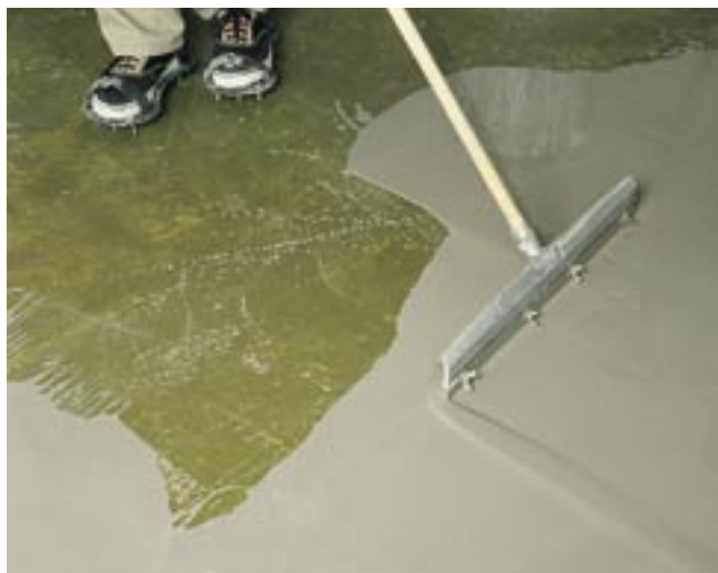
Samonivelační stěrky PCI lze díky až 40 minutovému rozlivu zpracovávat pohodlně vestoje raklí.
