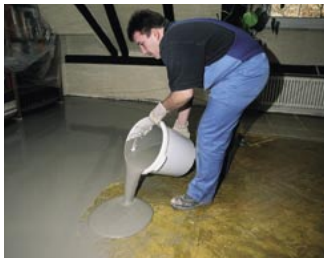
Aplikace Stěrky na dřevěné podklady HSP 34 na dřevěný podklad v tl. min 3 mm.
