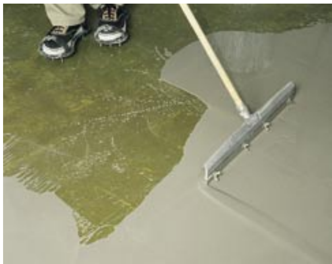
Samonivelační stěrky PCI lze díky až 40 minutovému rozlivu zpracovávat pohodlně vestoje raklí.
