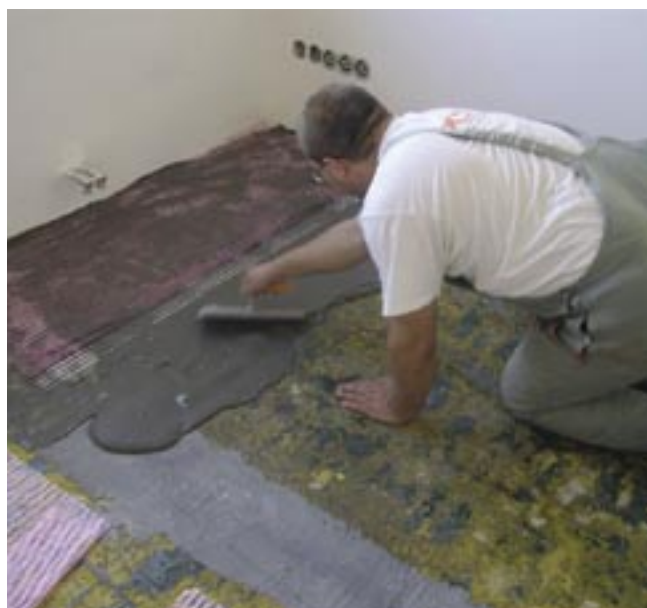
Aplikace Sešivací vložky GFS na rozpraskaný podklad se zbytky asfaltu.
